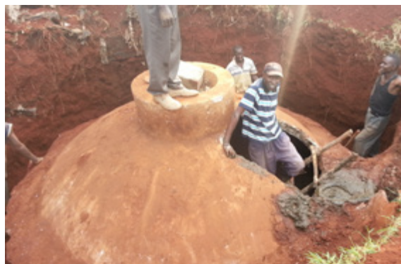
Endarbeiten bei der Biogasanlage
